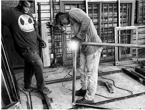
写真2 鉄工所での窓枠生産の様子
